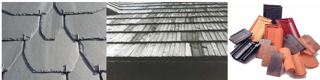
Eerste keuze: Natuursteen leien, houten shingles en keramische dakpannen (Bron foto 3: Koramic)
